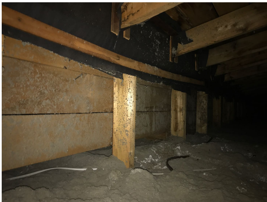
Entretoit de la sacristie : isolant en vrac, fermes et platelage de bois.
