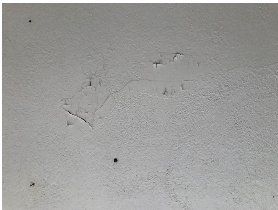
Exemple de réparation de fini (mur de l'entrée principale)
