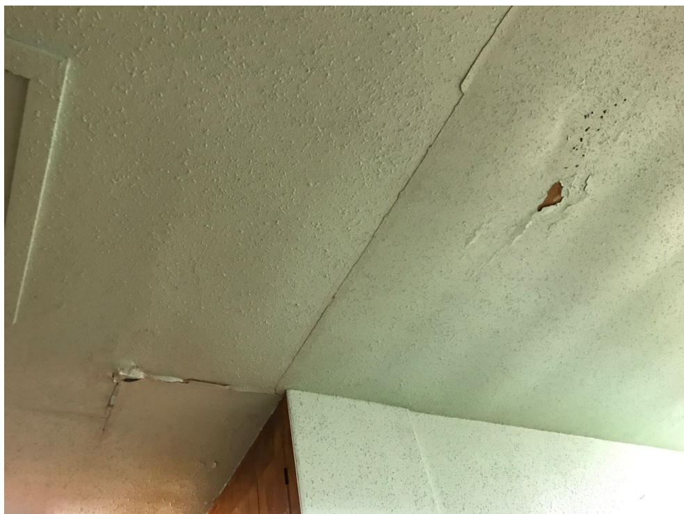
Exemple de réparation de plafond (sacristie)
