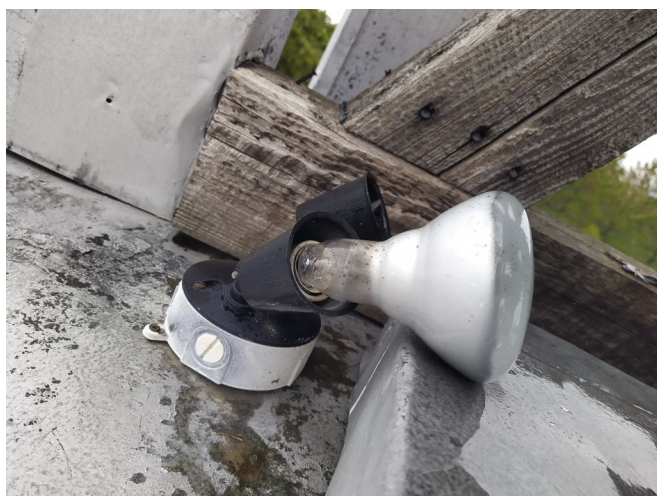
Éclairage du clocher à remplacer
