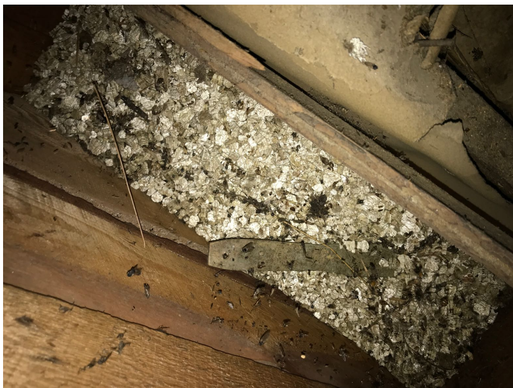
Isolant en granules observé dans les cavités murales, par l'entretoit (s'apparente à de la vermiculite).
