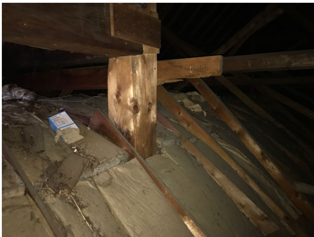
Isolant de laine laminé d'un papier kraft (dôme de la nef)
