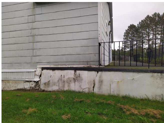
Câble de mise à la terre du paratonnerre à corriger.
