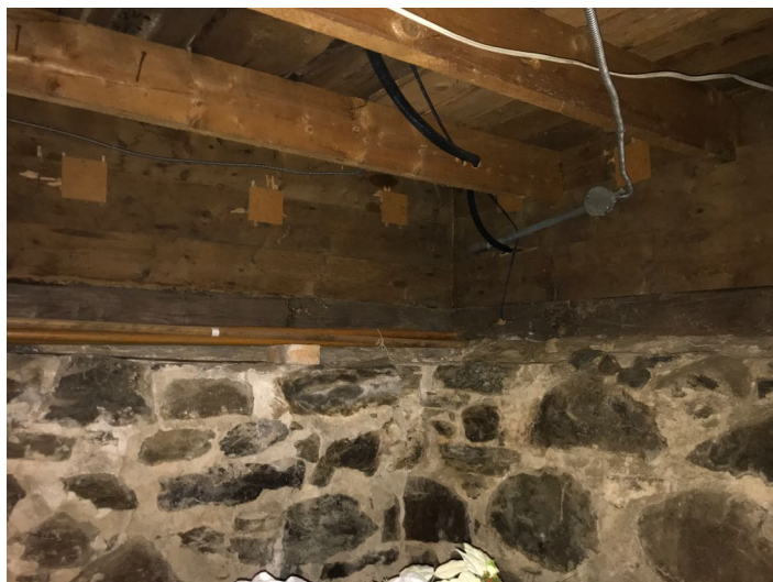
Vue du sous-sol
