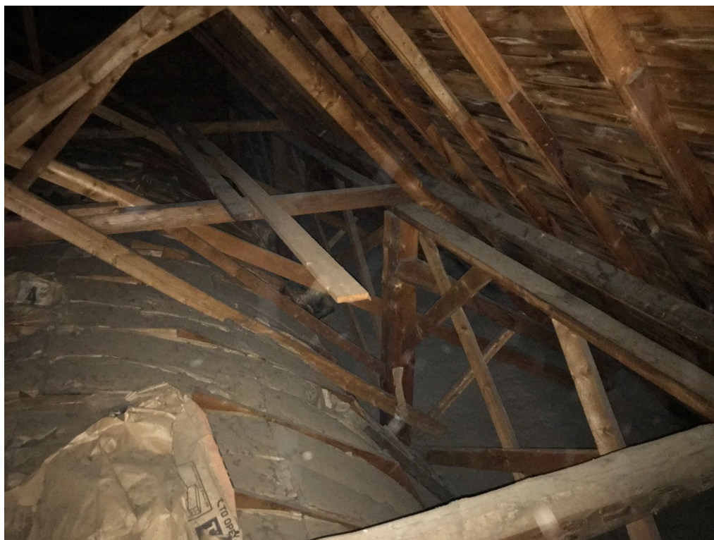
Structure de bois de la toiture principale
